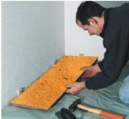
Para comenzar se necesita: Película de polietileno y cinta adhesiva. Como herramientas: metro plegable, lápiz, sierra de calar, martillo pesado (mazo), regla para nivelar, hierro de tracción, taco de madera y cuñas distanciadoras.
