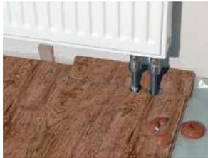
Para adaptar los tubos salientes de los calefactores radiantes, se tendrá que cortar un elemento o tabla al tamaño y cortarlo adecuadamente ajustándolo diámetro del tubo, luego volver a encolar el elemento y cubrirlo con rosetas para tubos de calefactores radiantes.
