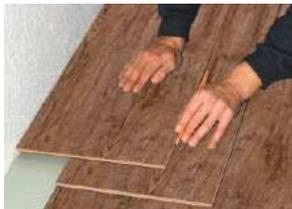
Ajuste la última hilera del parquet flotante colocándolo exactamente sobre la fila anterior. A continuación marque con ayuda de un trozo de parque a lo largo de la tabla, cortándola a lo largo de la marcación. Este corte será enganchado a la fila anterior con ayuda del hierro de tracción (figura).
